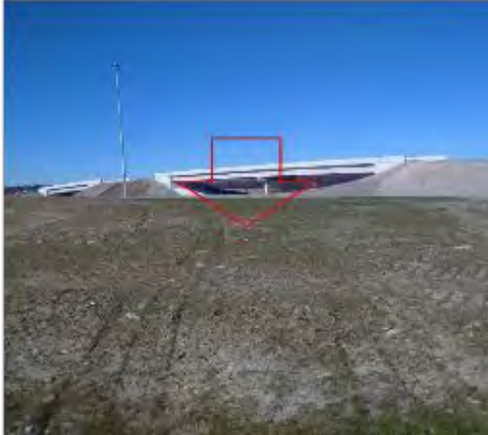
Vue de la bretelle d'accès de la 412 à la 407
