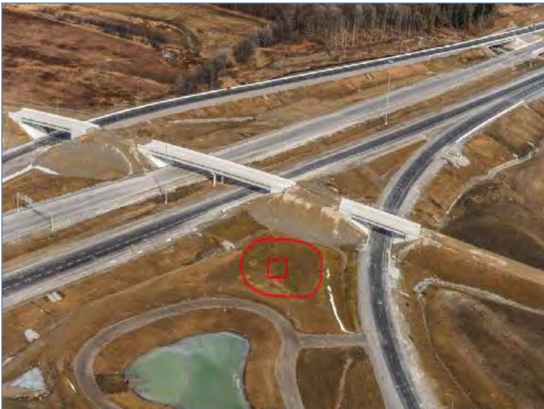
Emplacement de l'œuvre à installer.
